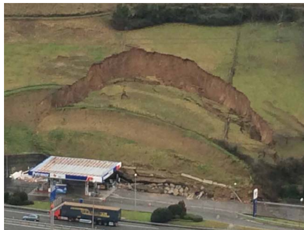
Fig. 2: Deslizamiento de Febrero de 2015.
