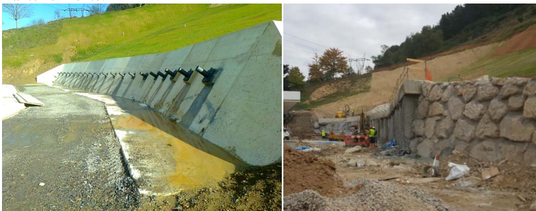
Fig. 5: Vistas muro anclado terminado (izda) y muro de escollera y pantalla de pilotes (dcha.).
