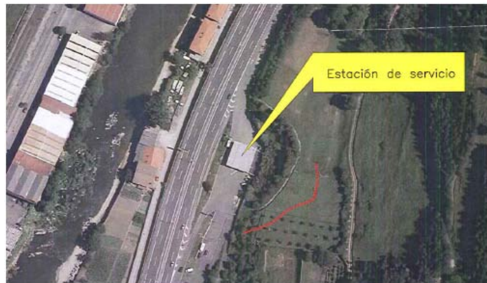
Fig. 1: Vista aérea de la zona de estudio en Abril de 2013 y posición de la grieta de tracción del deslizamiento.
