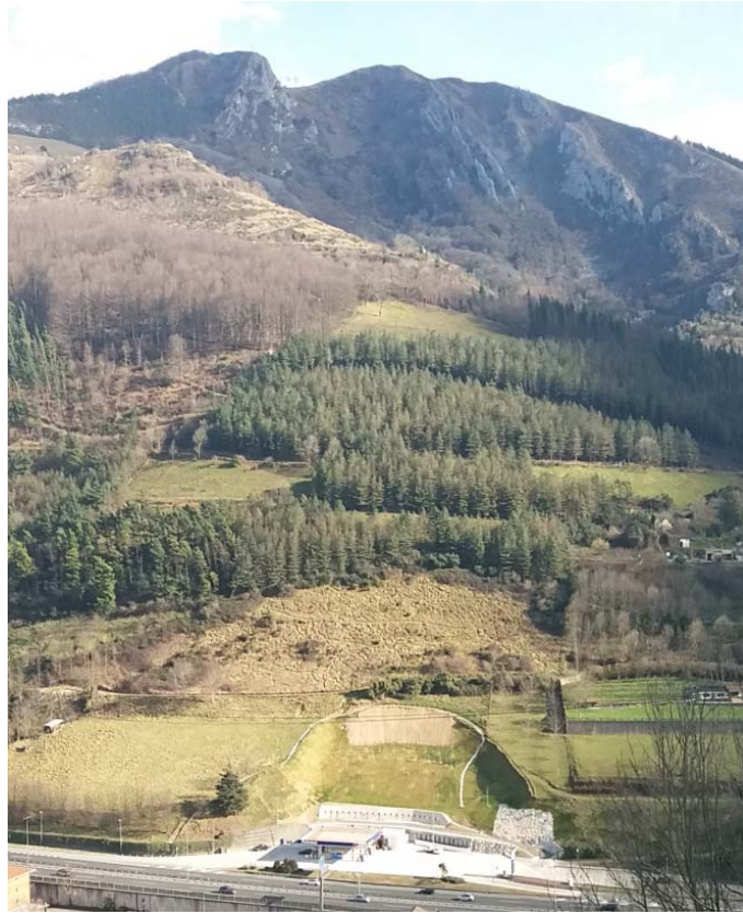
Fig. 3: Vista general obra terminada.
