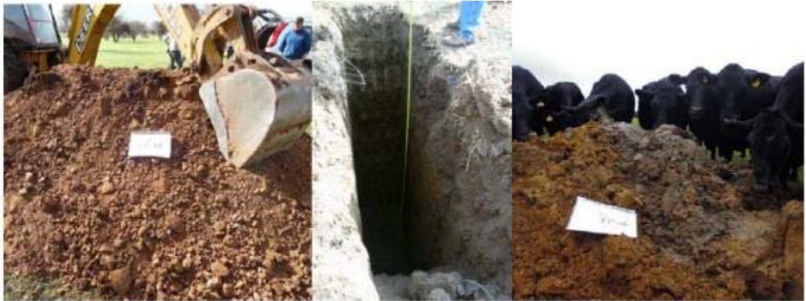
Fig. 1: Detalle de calicata mecánica para inspección y toma de muestras del terreno
