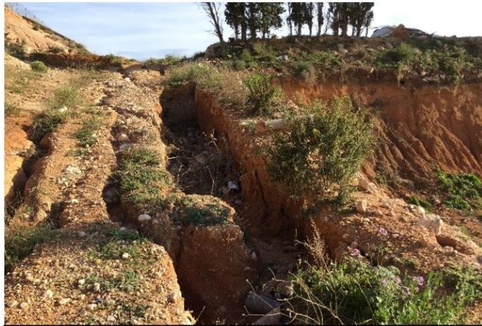
Ejemplo erosión en relleno antrópico en Murcia.
